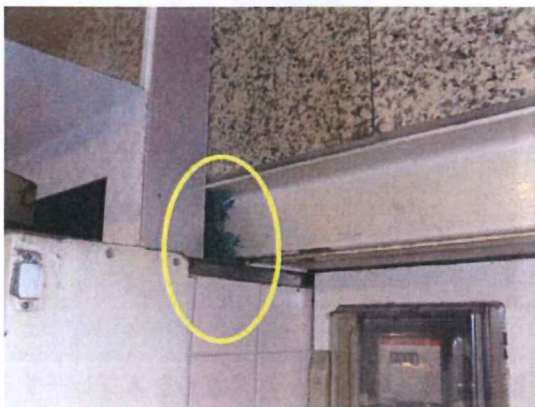
構造上隣接店舗からの進入も考えられるので防鼠ブラシを設置
