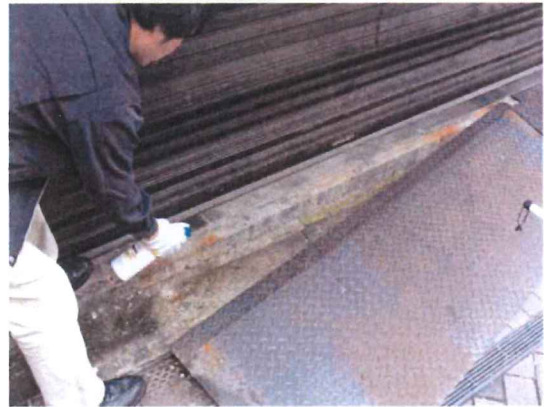
撤去清掃後ラットアウトをスプレー
