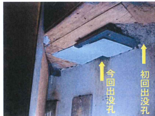
閉塞後周辺にもラットアウトをスプレーする
