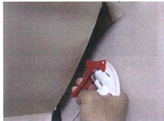
隙間よりラットアウトをスプレー
