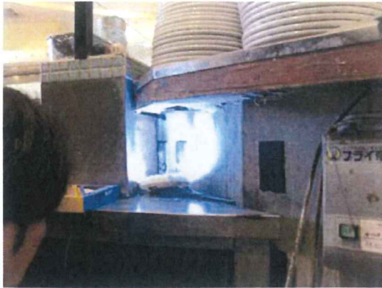
閉塞作業箇所のすぐ横に新たな侵入孔確認
