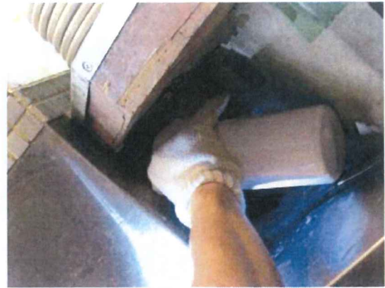
閉塞前に侵入孔からラットアウトをスプレー
