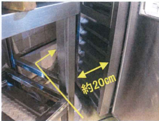
出没箇所はかなり狭くなっており作業は困難
