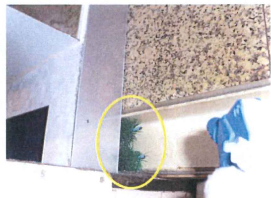
防鼠ブラシ及びラットサインの認められる箇所にもラットアウトをスプレーする
