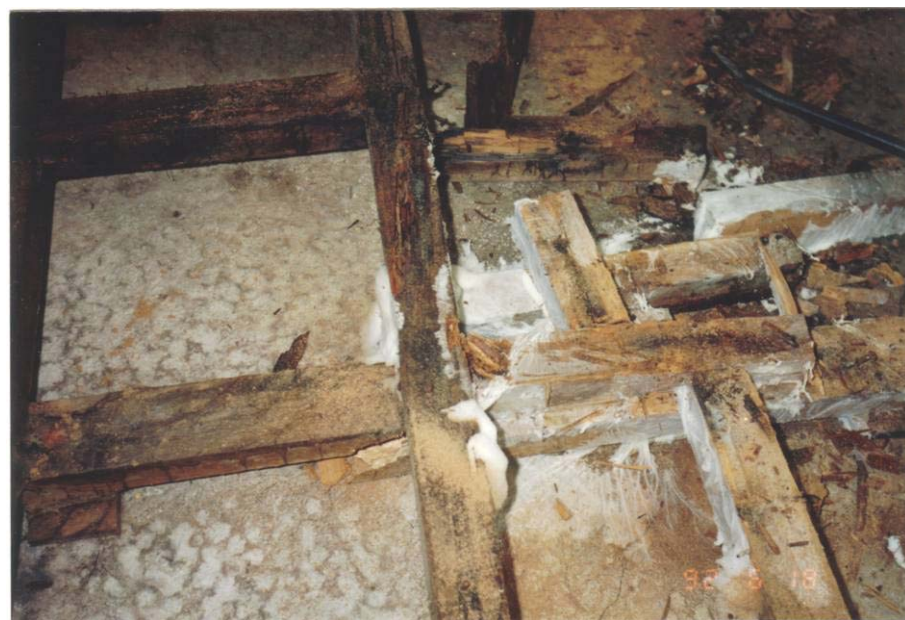
木材腐朽菌による被害
