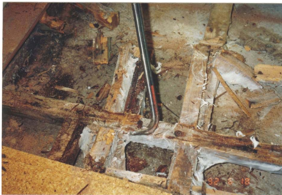
木材腐朽菌による被害
