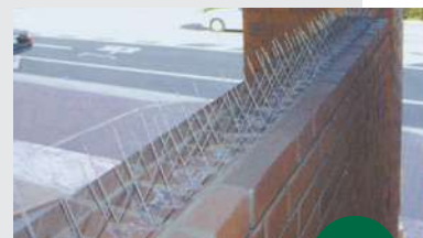
▲鳥の隙間への侵入を防ぎます。
