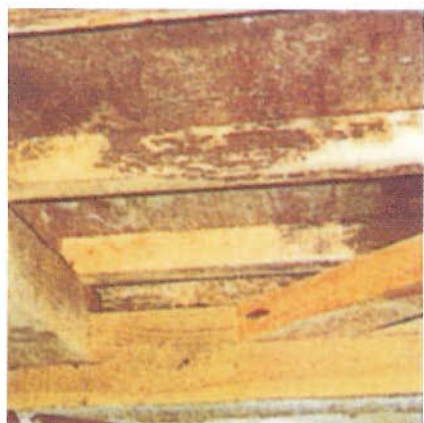
白アリ 白アリが発生し家の強度が落ちる
