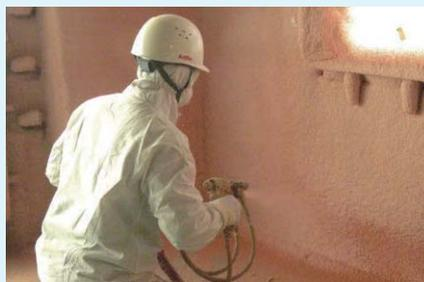
コンクリート壁への現場発泡ウレタン施工例
