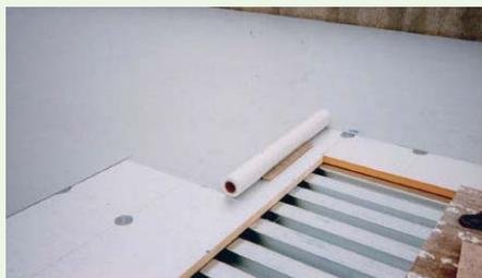
屋上断熱防水施工例(シート防水機械式固定工法)
