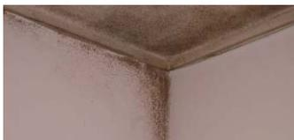
壁・天井の結露によるカビ発生例
