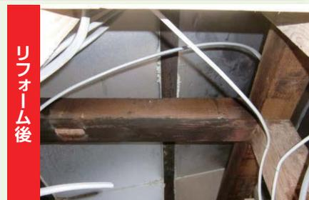
屋根裏面への断熱ボード施工前後例
