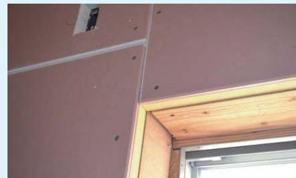
下地材への断熱複合パネル施工例
