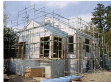
キューワンボード外張り工法施工例 (新築)
