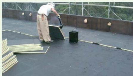
屋上断熱防水施工例(アスファルト熱工法)
