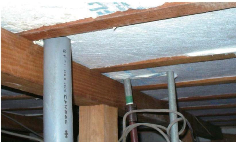
柔軟で曲がりやすい性質を活かし施工性に優れた、既存床下からの断熱リフォーム専用断熱材です。
